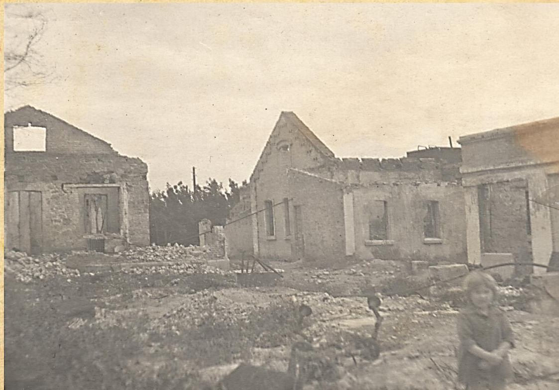
Фото. Разрушенные частные жилые дома в Сталино-заводском районе, г. Сталино 1943 г. ГА ДНР. Ф. Ф. Оп. 20. Инв. № 113
