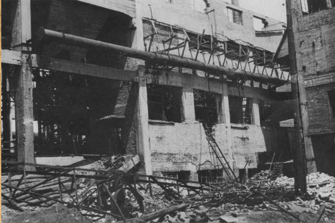
Фото. Разрушенный парокотельный цех Енакиевского коксохимического завода, г. Енакиево 1943 г. ГА ДНР. Ф. Ф. Оп. 20. Инв. № 81
